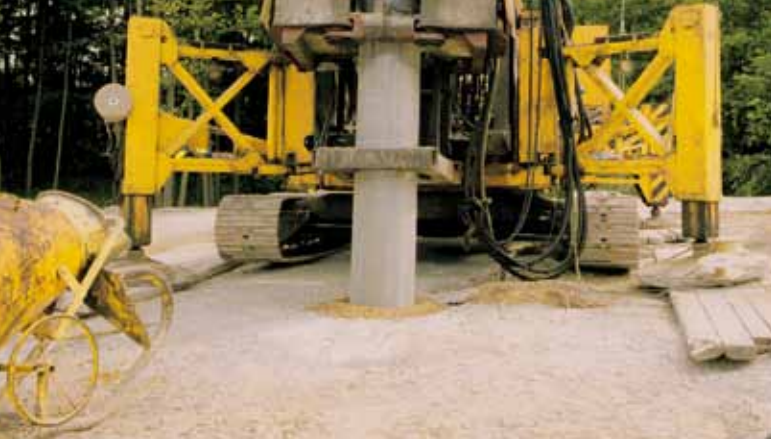
Ziehen des Rohres
