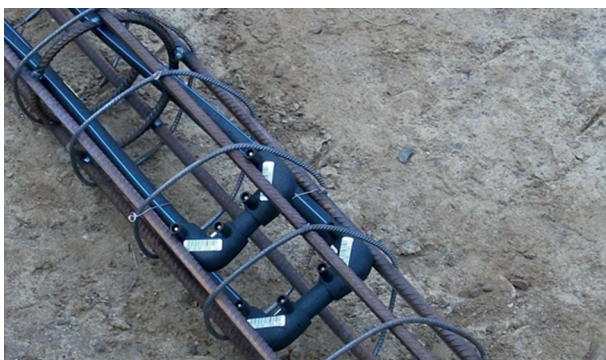
Das Wärmeübertragungsrohr als Doppel-U eingebaut
